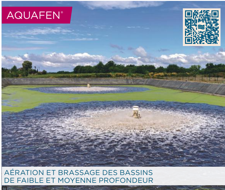
Aération de surface
